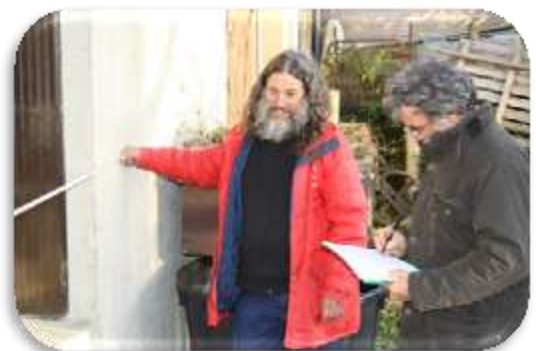
Diagnostic bâti à la ferme du Pointeau
